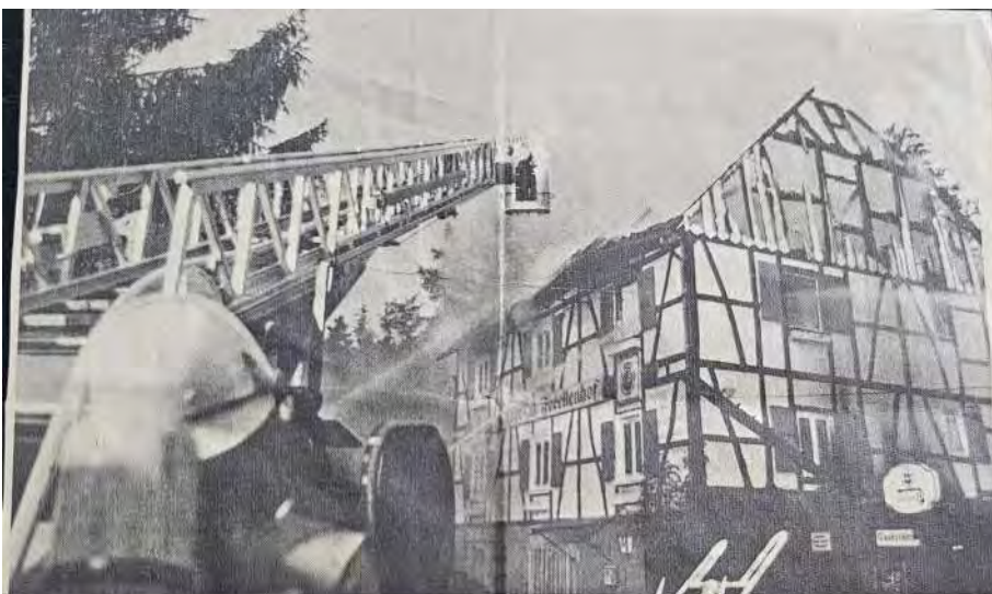
Bis auf die Außenmauern brannte das alte Fachwerkhaus ab. Es ist vom Einsturz bedroht und wurde geschlossen. Fotos: Lenz
